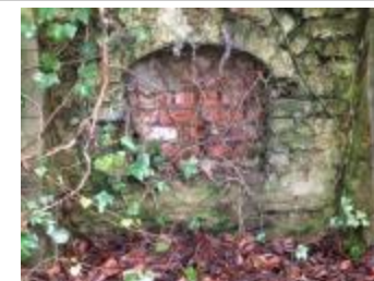
De beerput van het domein Gevaert-Minne (SML_MGM_MVDA_2015_beerput)
