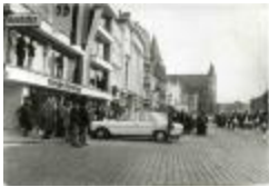
Uitbreiding meubelzaal Van de Voorde (D_2014_MM_DVN_LvDV008)
