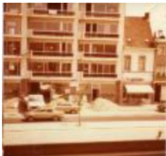
De bouw van appartementencomplex 'De Volkskring' (D_2014_MM_DVN022)
