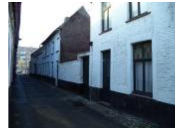
beluikhuisjes aan de Kattestraat (D_POLS_MVDA_2015_arbeidershuis)
