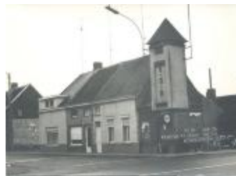
De elektriciteitscabine in de Gentspoortstraat (mudel_Fo.1786.DEI.025.jpg)
