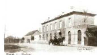
De achterzijde van het station van Olsene (Z_HKZ_MVDA_2014_004)
