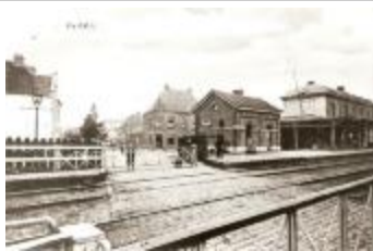
Het station van Olsene met overweg. (Z_HKZ_MVDA_2014_005)
