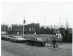
Schutterswip in het centrum van De Pinte (DP_CM_MVDA_2016_83a)
