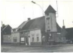
De elektriciteitscabine in de Gentpoortstraat (mudel_Fo.1786.DEI.025.jpg)
